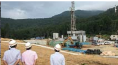
湯沢地熱発電所を視察
